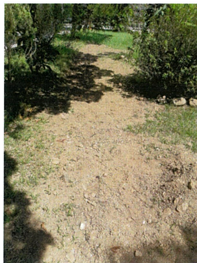
施工完後覆土
